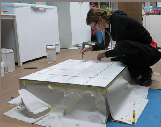
Bijpassende lage sokkel maken van MDF
